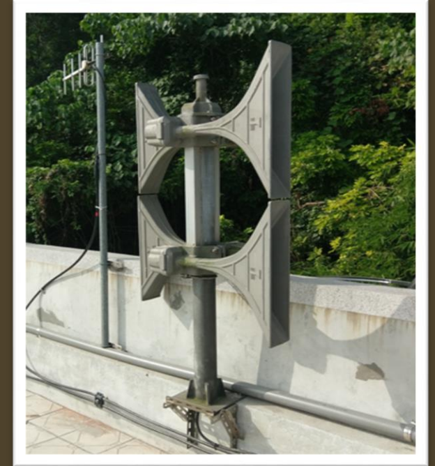
電子式警報器： 透過微控制器使電 路板產生警報音頻
