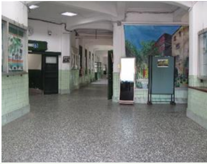
門廊入口大廳多處改建
