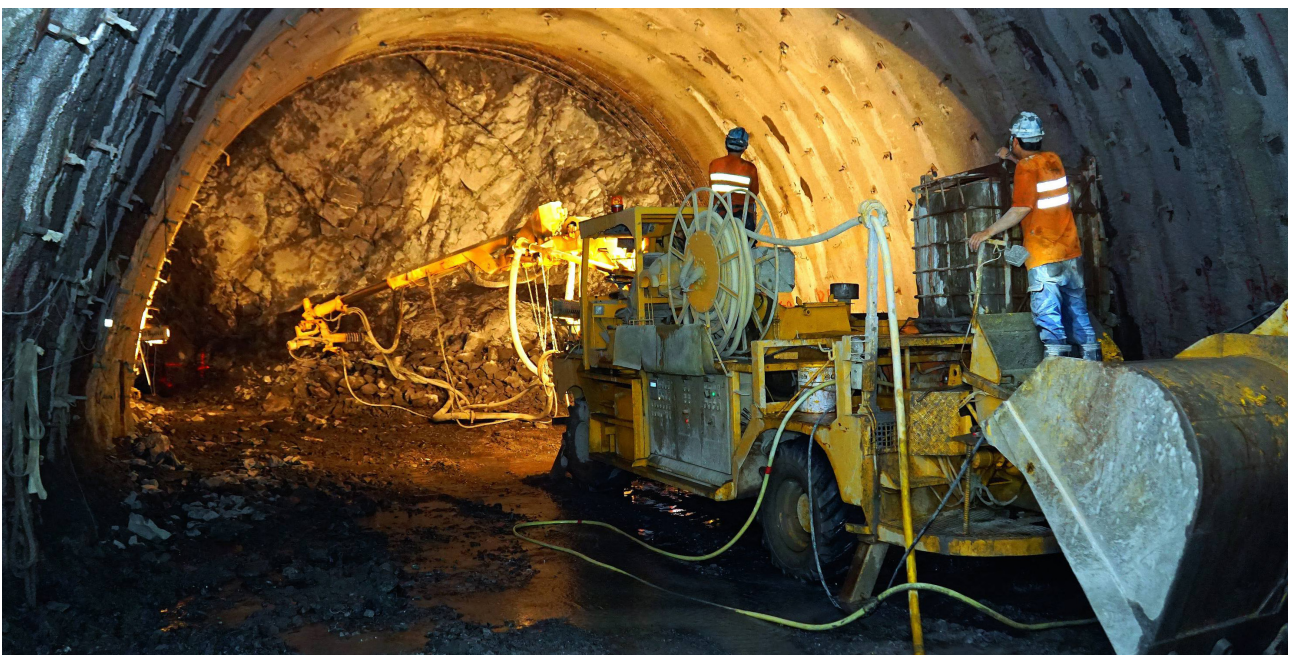
▲ 台9線南迴公路安朔草埔段隧道工程—鑽保機鑽孔施工。
