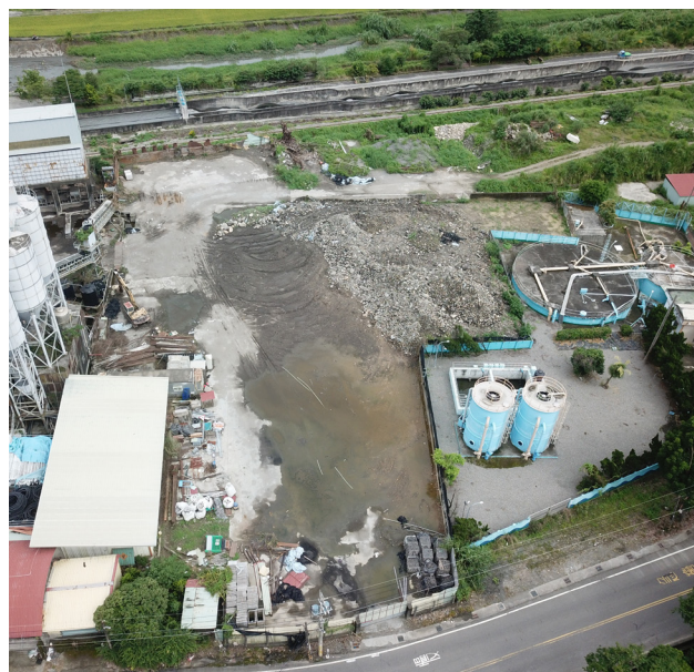
▲ 彰化縣二水鄉自來水廠旁無機污泥棄置場址回復景象。
